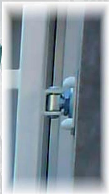
Pri montáži kovaných brán sa používajú závesy s nastaviteľnou kontramaticou. Podľa druhu spoju s nosnou časťou sú nastaviteľné alebo s kotviacou platňou.
