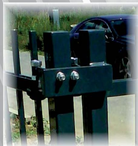
Po zatvorení brány jej tuhosť a stabilitu zabezpečuje doraz. Narozdiel od samonosnej postačuje vďaka vodiacim kolieskam iba jeden a to horný.
